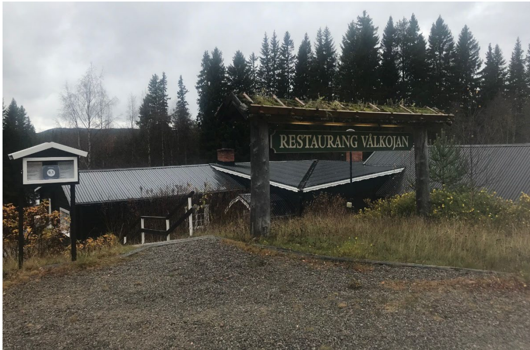
Befintlig huvudbyggnad sedd från tillhörande parkering på Hån 4:24
