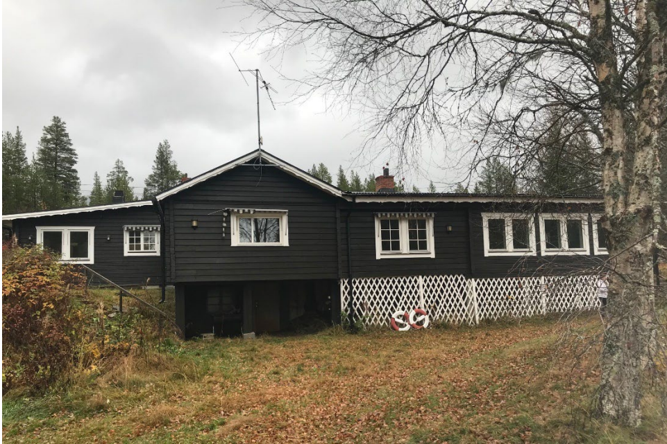
Ursprungliga huvudbyggnaden sedd från strandkanten (söder ifrån)
